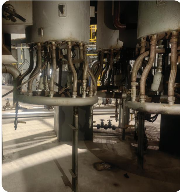
圖：苯加氫加熱爐煤氣垂直環形進口系統
