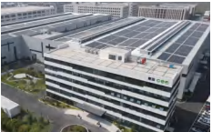
浙江复洁厂房屋顶光伏
