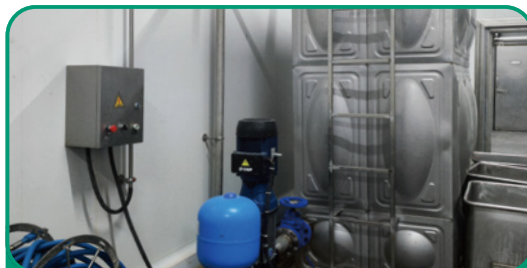
▲ 冷凝水回收水箱及控制水泵
