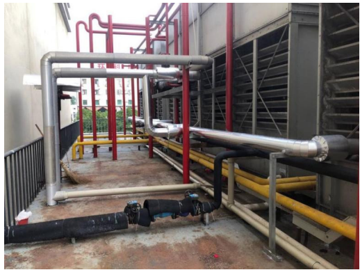
项目改造现场图
