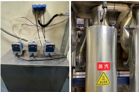
项目改造现场图
