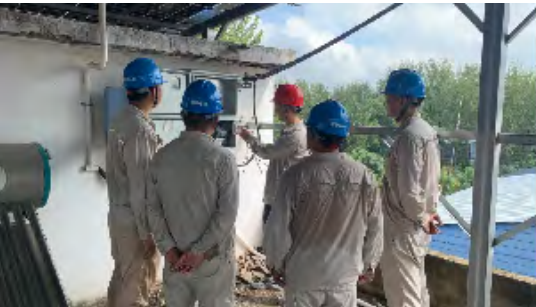
技术人员对现场实施班组讲解规范安装要点
