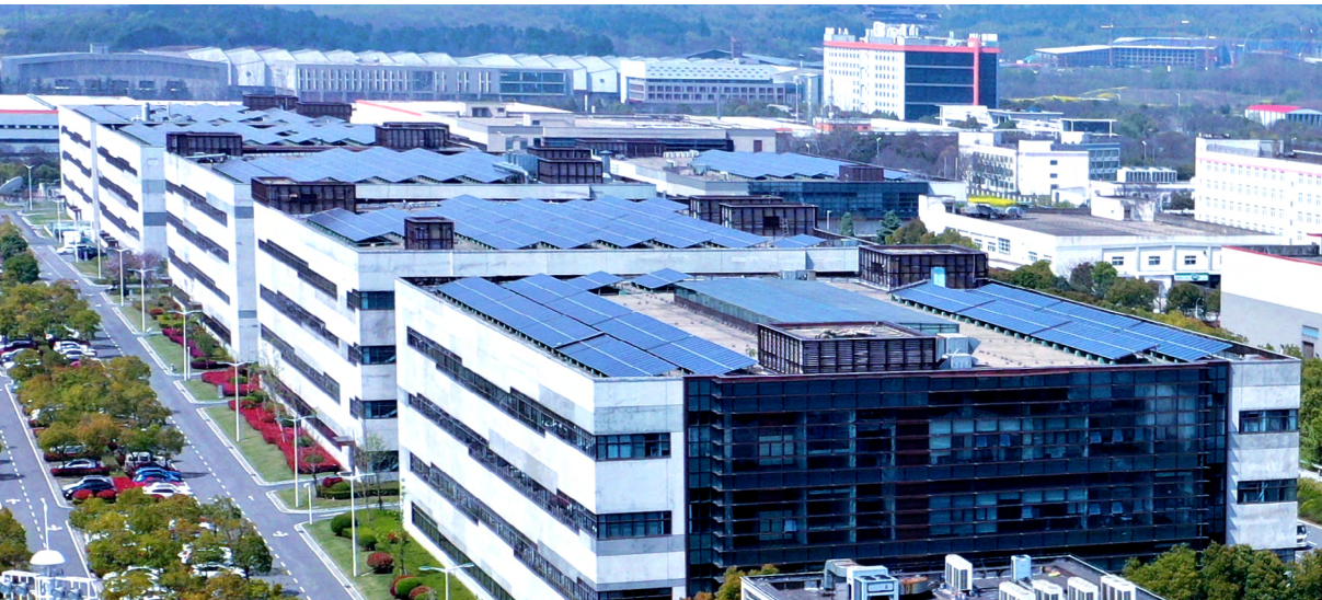
园区屋顶光伏设施
