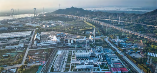
扬镇直流圖山换流站和五峰山大跨越输电线路
