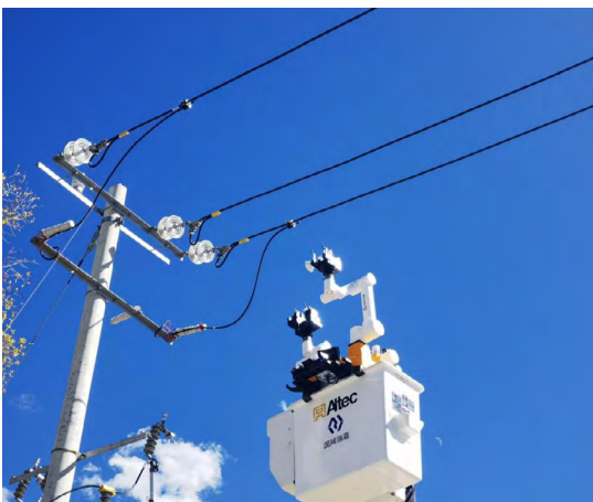
国网海东供电公司首次使用配网带电作业机器人完成带电加装接地挂环作业
