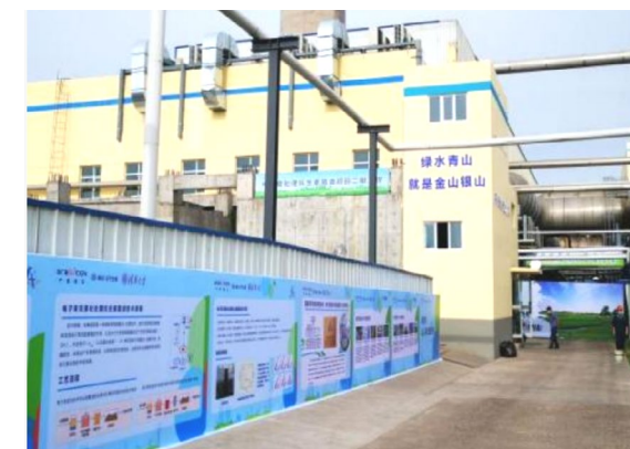
新疆伊宁中国首个电子束无害化 处理抗生素菌渣示范项目
