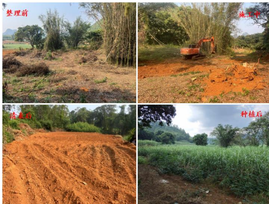
广西崇左市江州区某土地整治项目
