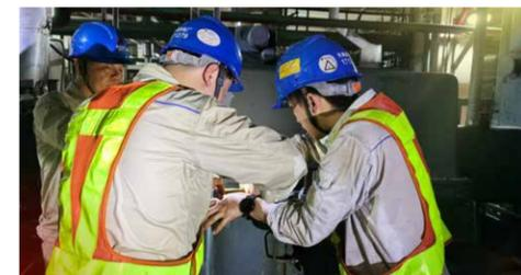
战高温、斗酷暑，史上第二连续高温 51 天，外高桥电厂检修部汽机一班员工开展 2 号机组电泵润滑油滤网清洗工作
