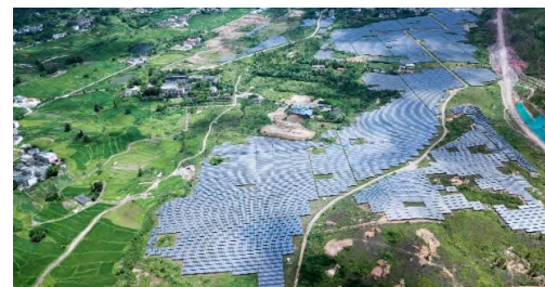
中设国联江西赣州于都仁风40MW地面光伏发电项目
