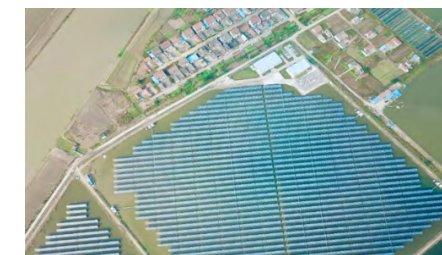
中设国联江苏连云港云台50MW地面光伏发电项目
