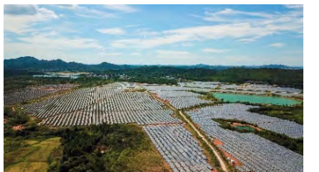
中设国联江西景德镇乐平65MW地面光伏发电项目照片
