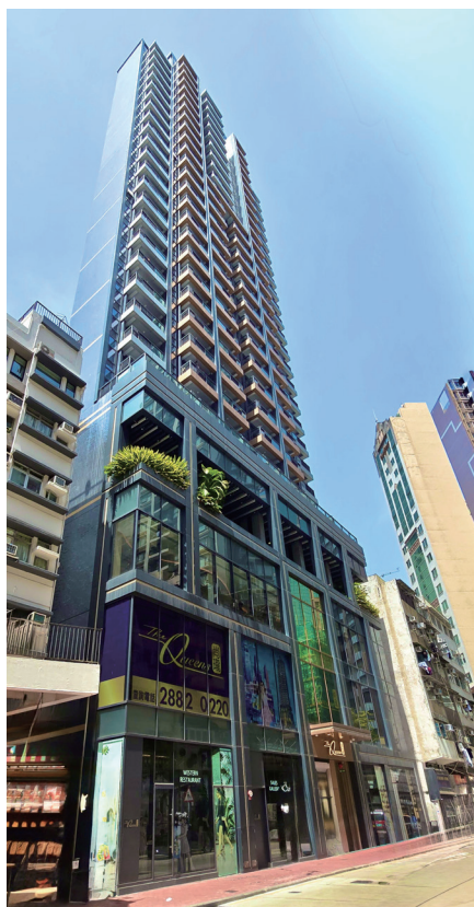
已於二零二二年八月竣工
