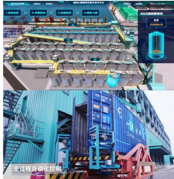
董家口分公司建成糧食碼頭全流程智能管控系統，實現設備自動化、流程協同化、安全風險識別智能化等多項關鍵技術突破。通過該系統應用，提升作業效率超 10%，碼頭通過能力增加超 15%，糧罐周轉率提高超 10%，每年預計可節約能耗費用超 100 萬元。
