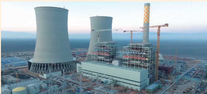
“疆电入渝”配套电源大基地煤电项目工程建设全力推进
