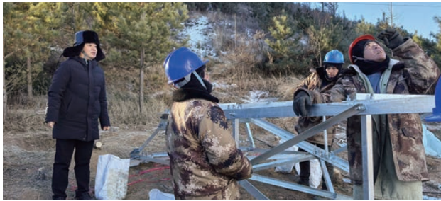
京津冀新能源公司 EHS 部对西龙头项目送出线路组塔现场进行监督检查
