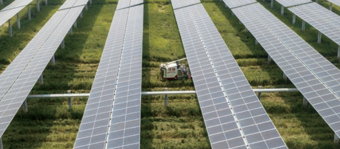
赤壁日曜350MW渔光互补光伏发电项目
