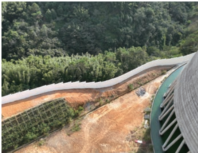
云浮公司设置降噪墙减少噪声对员工的职业健康危害
