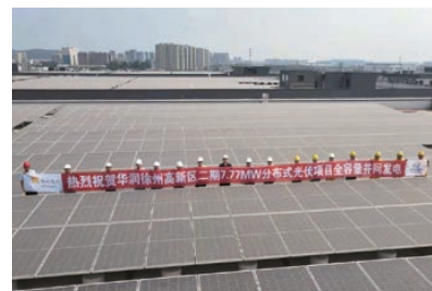
江苏徐州高新区二期7.77MW分布式光伏发电项目全容量并网
