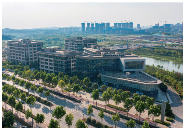
長沙億達中建·智慧科技中心
