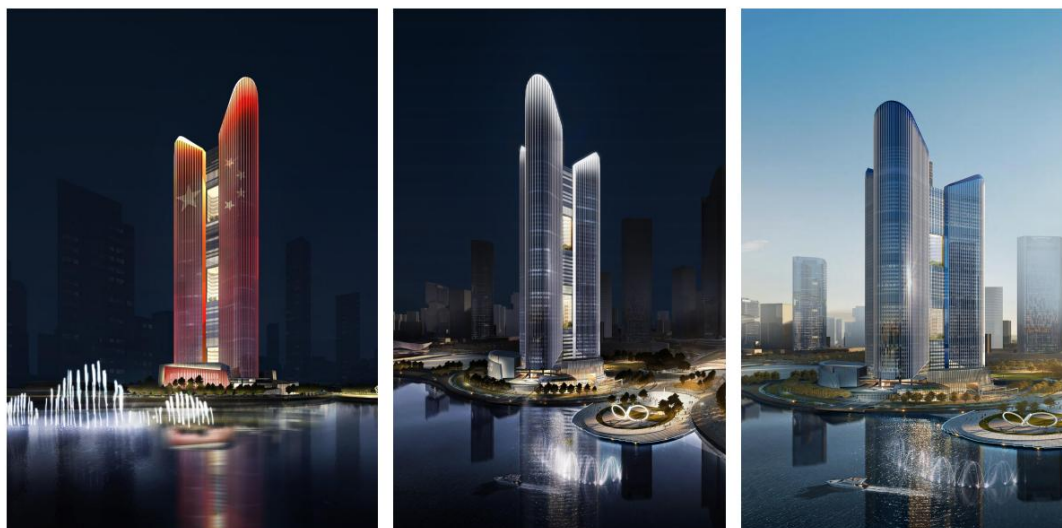
中新广州知识塔 JLXC-F1-1 地块知识塔项目外墙泛光照明专业承包
