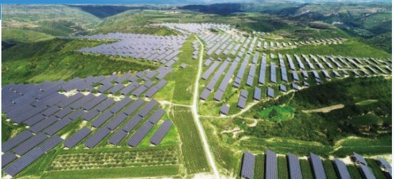
宜君农光互补光伏电站项目全景
