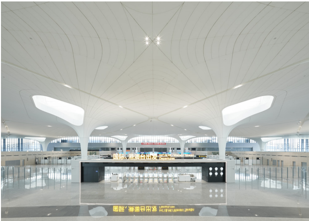
©杭州萧山国际机场三期项目新建航站楼
