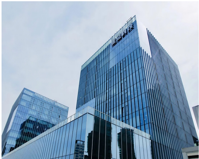
©南京焦点科技大厦（一期）幕墙及外装饰工程
