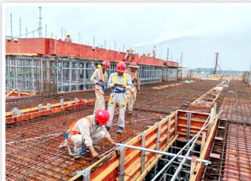
華誼項目預埋件安裝檢查驗收
