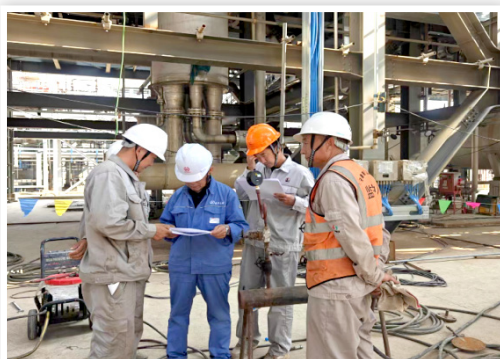
陽煤項目工藝管道試壓檢查
