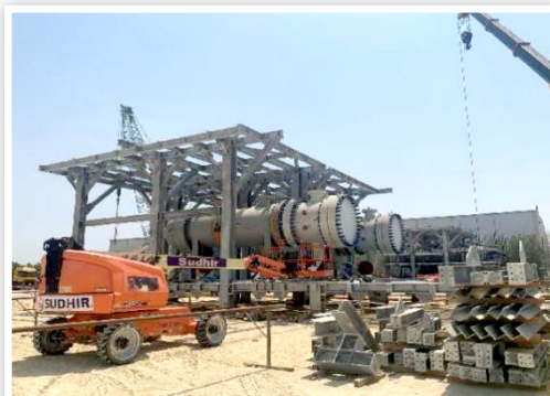
DPCU 項目設備模塊組裝檢查
