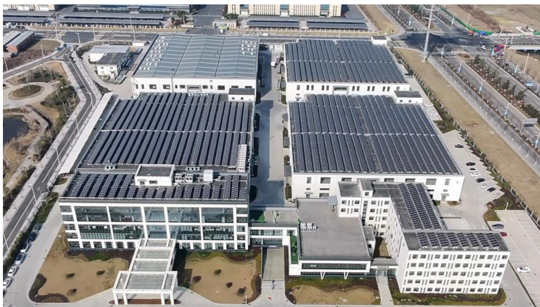
图一：厂房屋顶所配备的光伏发电系统
