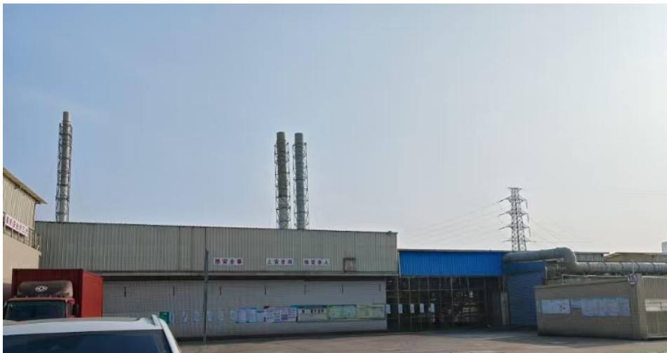
广东省污水处理厂改扩建项目
