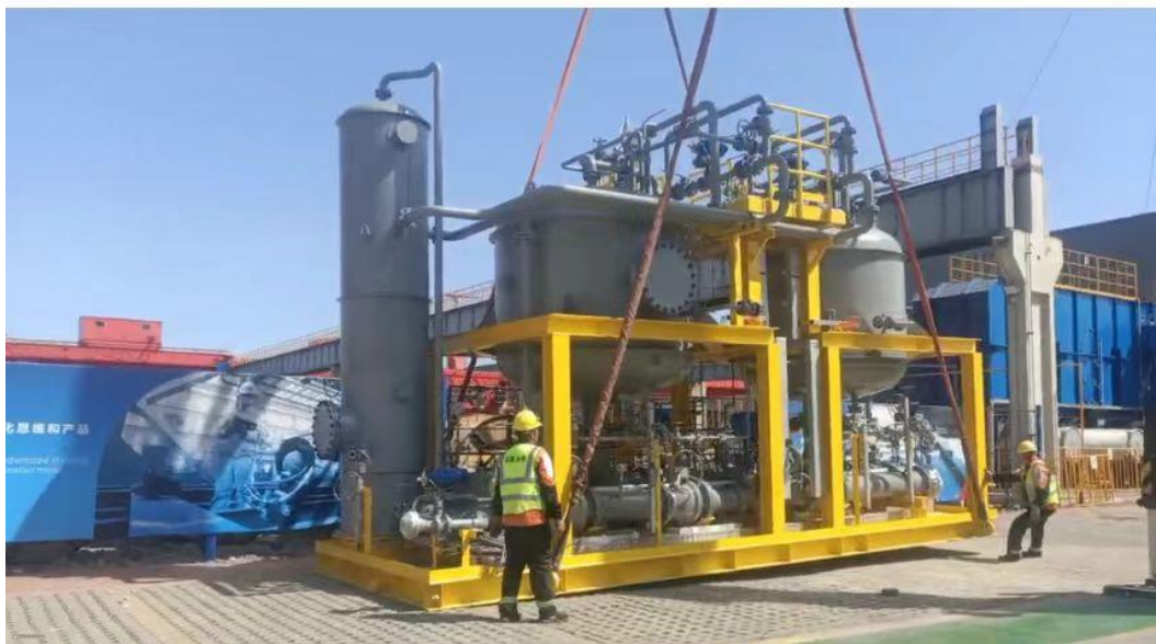
广西壮族自治区油田群生产处理中心优化项目
