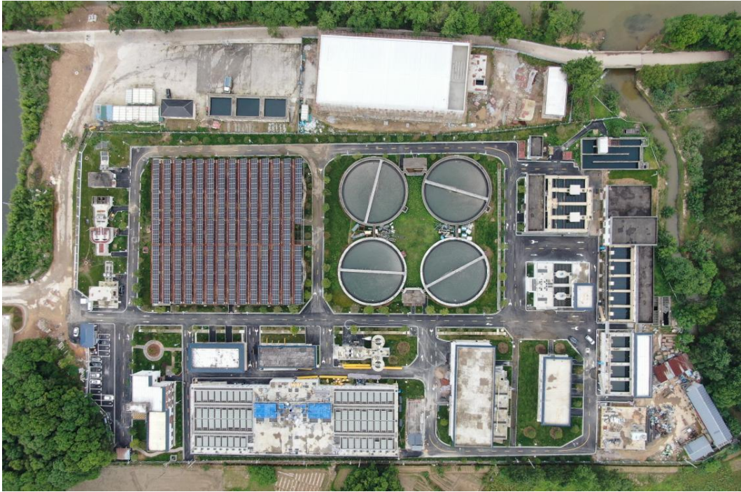
江西省污水处理厂扩建项目 工艺：A 2 /RPIR 出水标准：一级 A 新建设施、扩容提标（20,000 吨/日）
