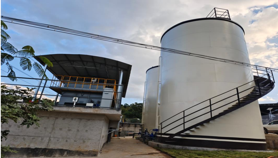
云南省咖啡废水处理项目
