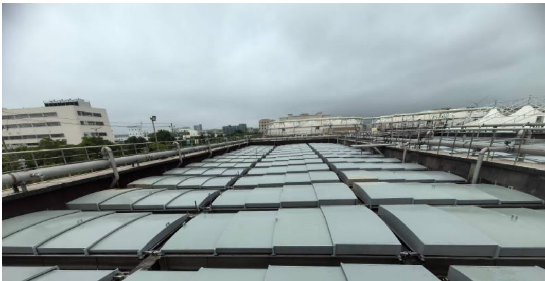
浙江省污水处理厂提升改造项目 工艺：A 2 /RPIR 出水标准：《城镇污水处理厂主要水污染物排放标准》（DB33/2169 - 2018）中现有城镇污水处理厂主要水污染物排放限值 原位扩容、无需征地（25000 吨/日）
