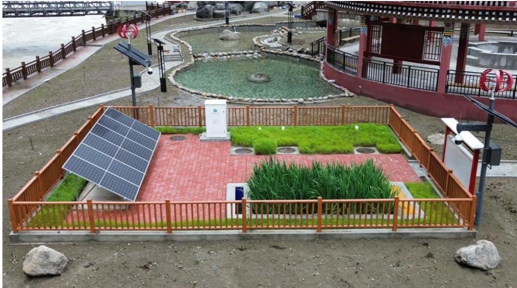
西藏自治区农村污水处理项目
