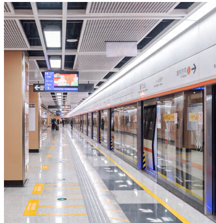
地铁车站低压配电
