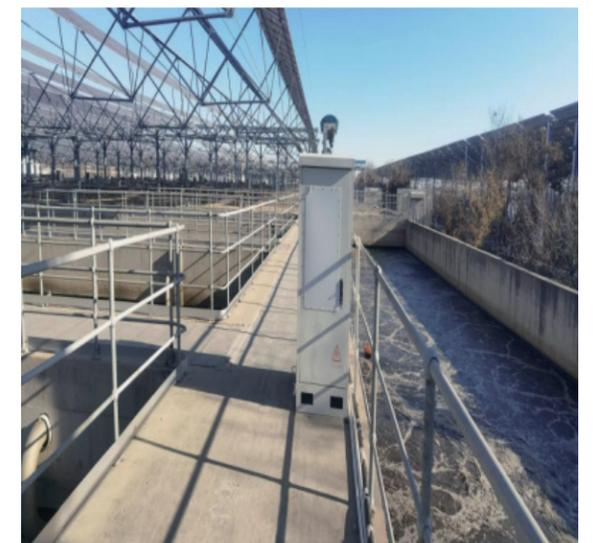
▲ 固定式溫室氣體在線監測設備
