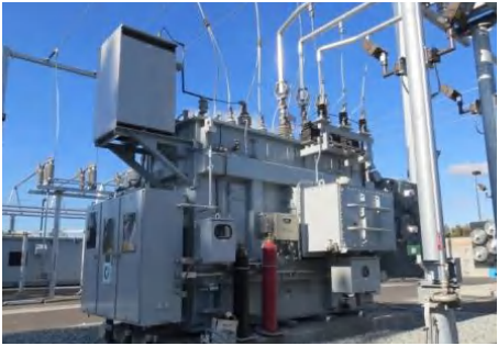
江苏镇江丁卯220kV 变电站改造工程
