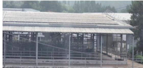
泰顺牛舍光伏发电设施
