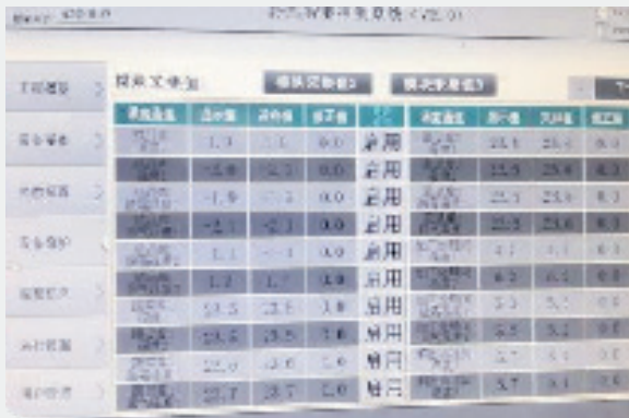
冷库智能检测系统
