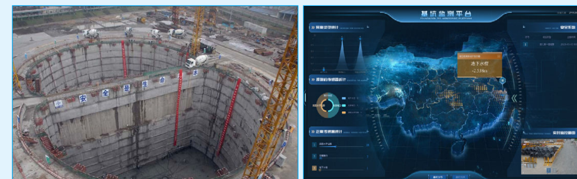
基坑项目现场及智能监测展示平台
