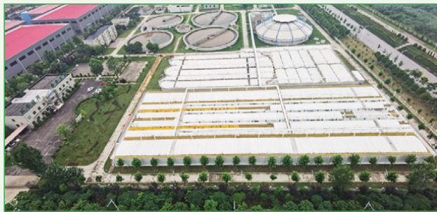
宝鸡高新区污水厂（10万吨/日）
