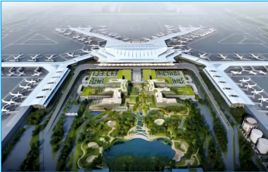
厦门新机场民航专业工程
