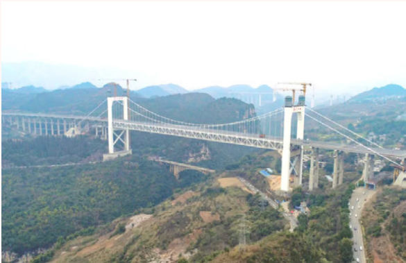
黔西南金州大桥
