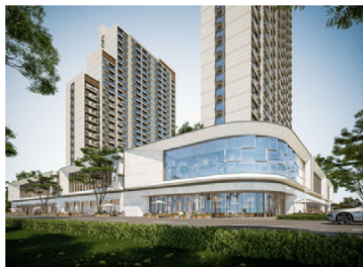
凤南一村小区旧住房更新（拆除重建）项目
