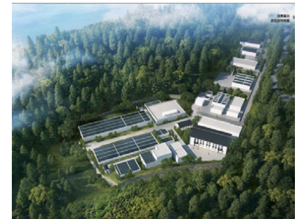
普陀山污水处理厂应急改造及运维服务项目
