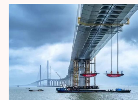
黄茅海跨海通道
