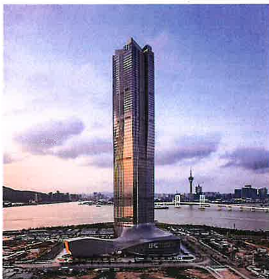
图1 横琴国际金融中心大厦项目实景图
