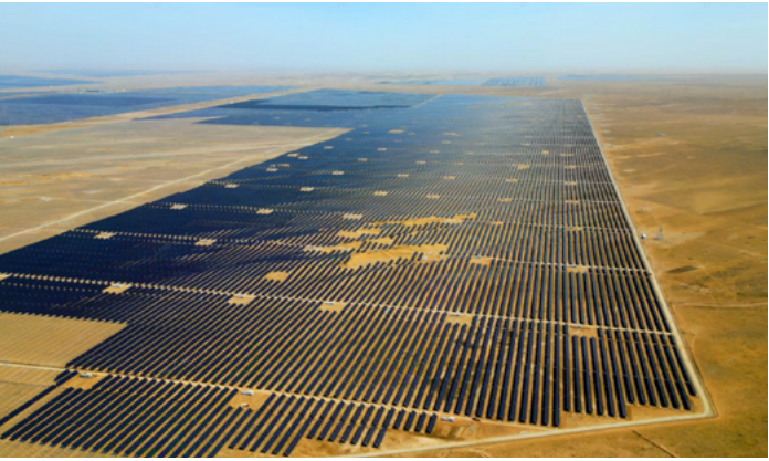
海南基地 100 万千瓦光伏项目
