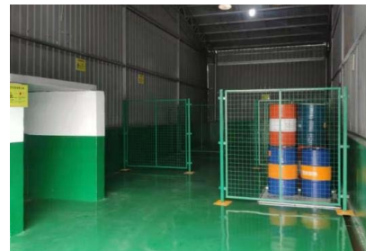
危险废物仓库
