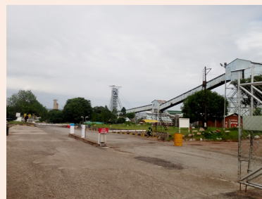
赞比亚 KCM 公司康克拉铜矿工程
