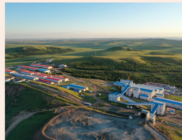
蒙古国乌兰铅锌矿采供矿工程
