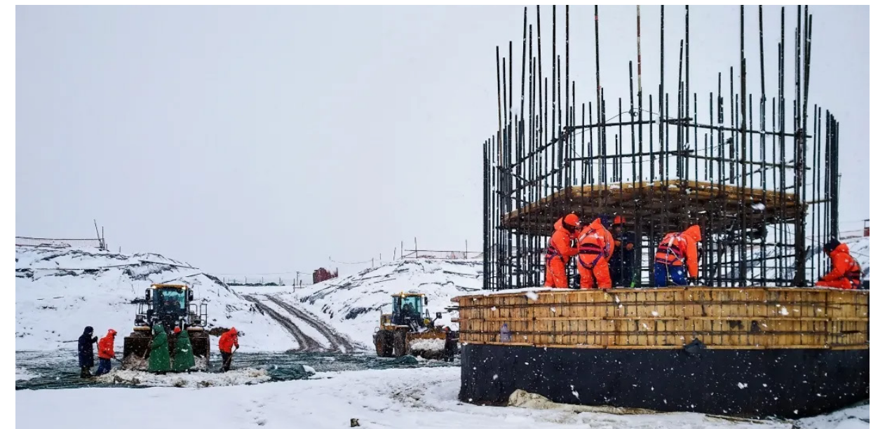
铜冠矿建哈萨克斯坦 VCM 项目在雪天的施工现场
