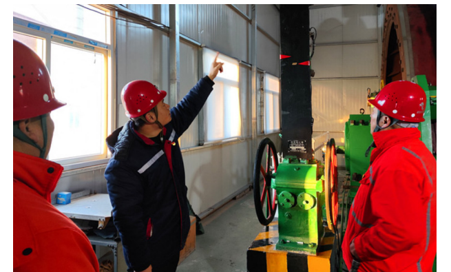
朱郭李家项目部对副提卷扬机、用电线路、消防设施等进行安全排查
