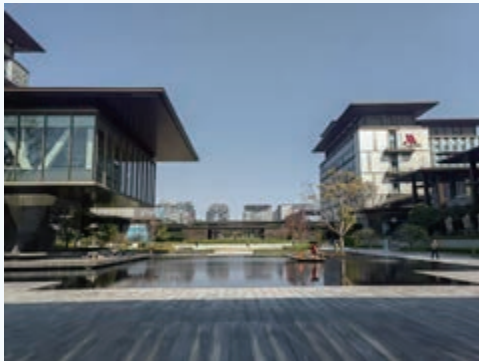
回收雨水用於園林水景池補水
