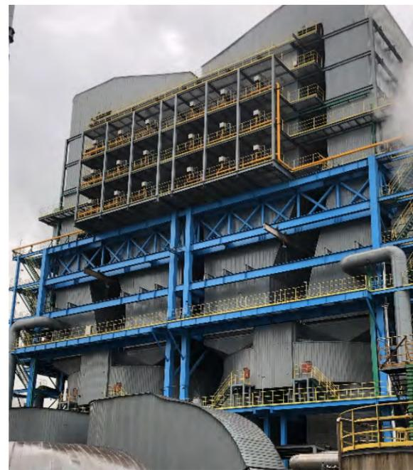
公司承建的日照钢铁 12#13# 烧结机烟气减白脱硝项目
