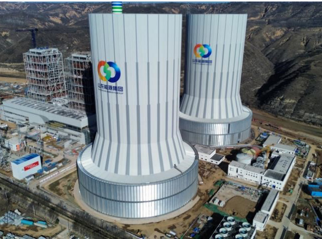
灵台 2×1000MW 全钢结构间接空冷塔
