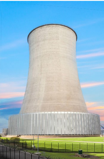
全钢结构间冷塔回收利用
