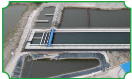
平流式沉淀池
