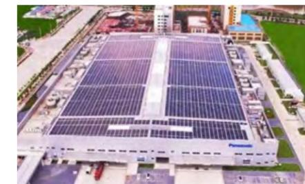
**项目简介**：建设东台基地，是晶澳科技推动产业升级、提升发展动能的关键举措。东台晶澳致力打造国际领先的灯塔工厂，将绿色化、高端化、智能化贯穿生产全过程。在此背景下，清源科技助力江苏东台晶澳 40.8MW 分布式光伏电站项目成功并网。该项目高效利用五栋厂房闲置彩钢瓦屋顶，建设 40.8MW 分布式光伏电站。清源科技凭借专业实力，为项目量身定制易捷大力神 SolarRoof Aeri 光伏支架安装解决方案及产品，实现了高标准交付。项目建成后，预计每年可产生高达 4612.94 万千瓦时的电量。
