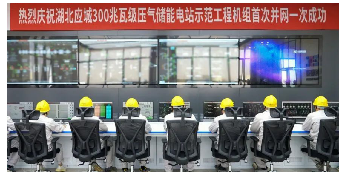
湖北應城300兆瓦級壓氣儲能電站示範工程首次並網一次成功
