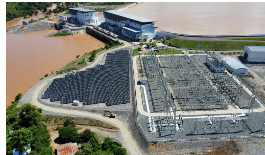
2024年7月1日，由東方電氣研製供貨的東薩宏水電站擴機專案——5號機組成功投運。
