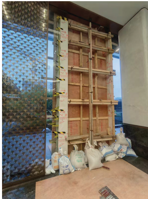
「格美」防颱前檢查 (售樓部出入口加固)
