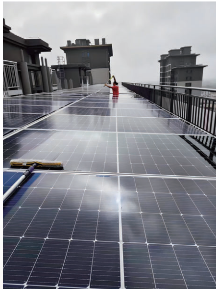
光伏組件 Photovoltaic modules
