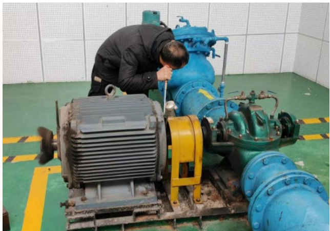
泵站巡检维修
