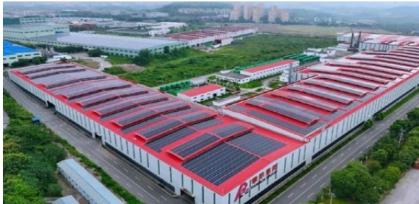
重庆攀华板材楼顶 5 万块太阳能光伏板
