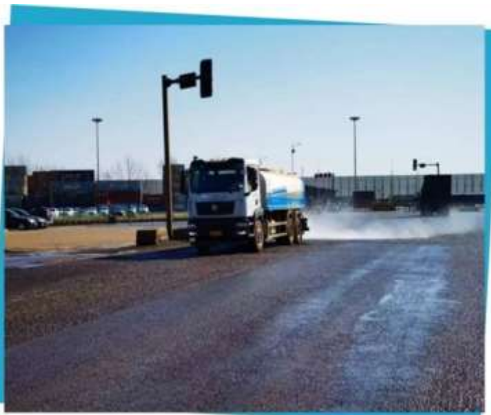
现场抑尘情况
