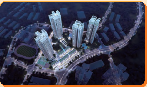
深圳鳳鳴水岸：海綿城市
