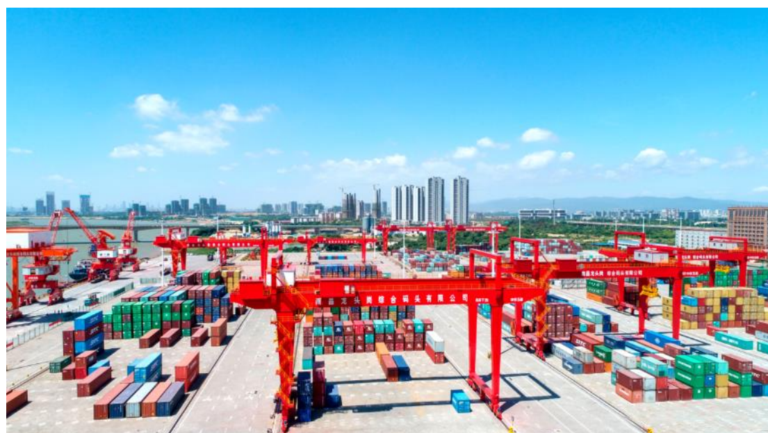
图：轨道式集装箱起重机施工实景
