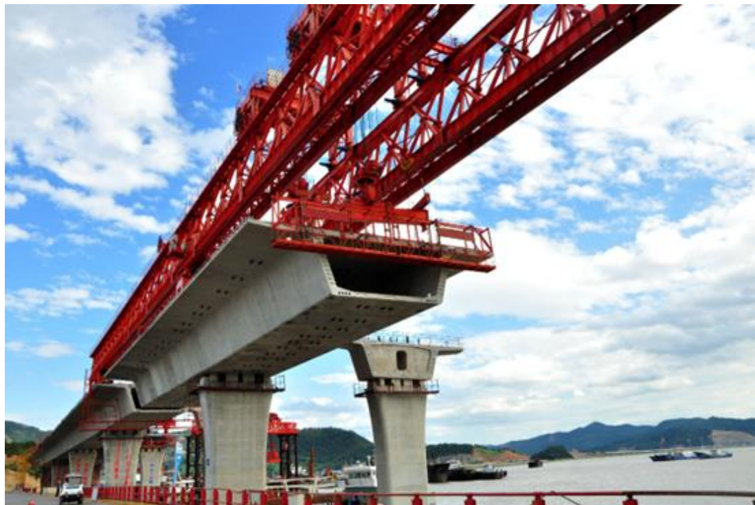
图：节段梁架设实景
