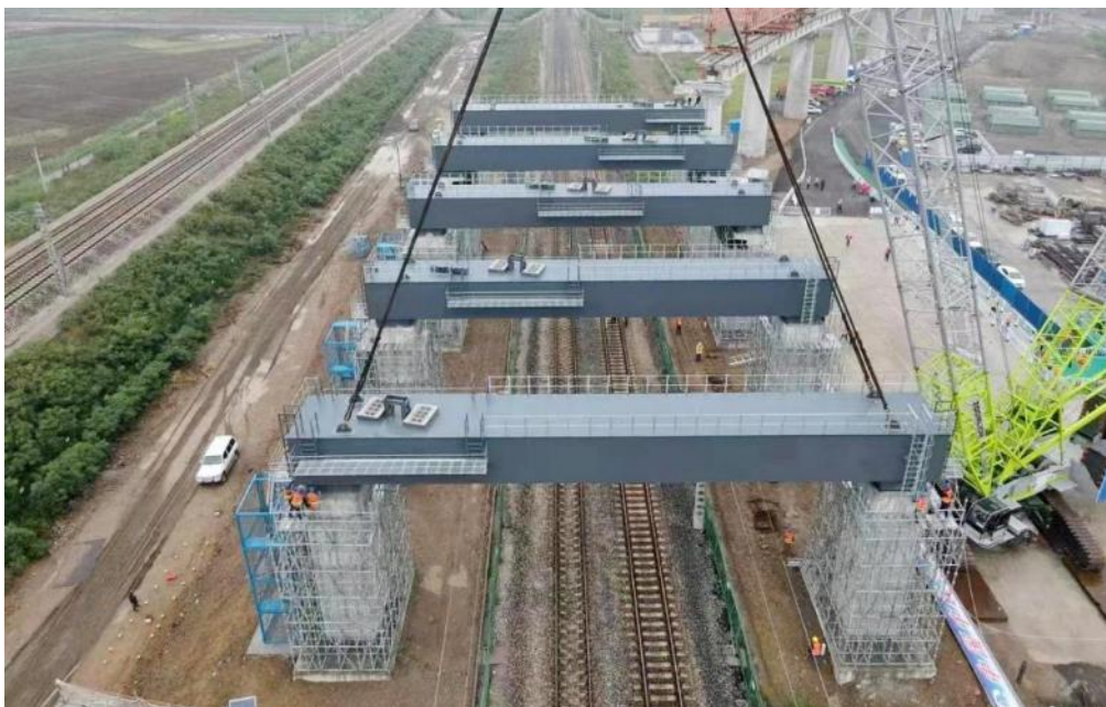
图：门式墩钢梁施工实景
