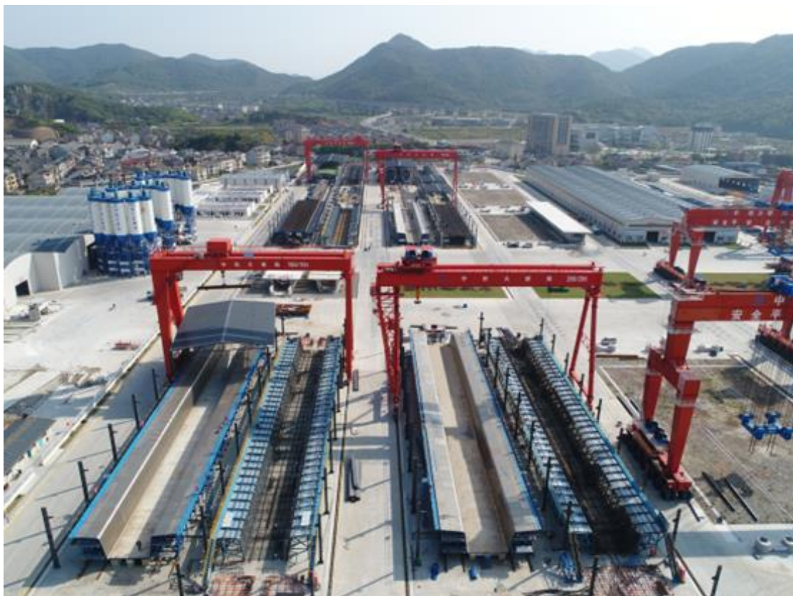
图：整孔梁预制场施工实景
