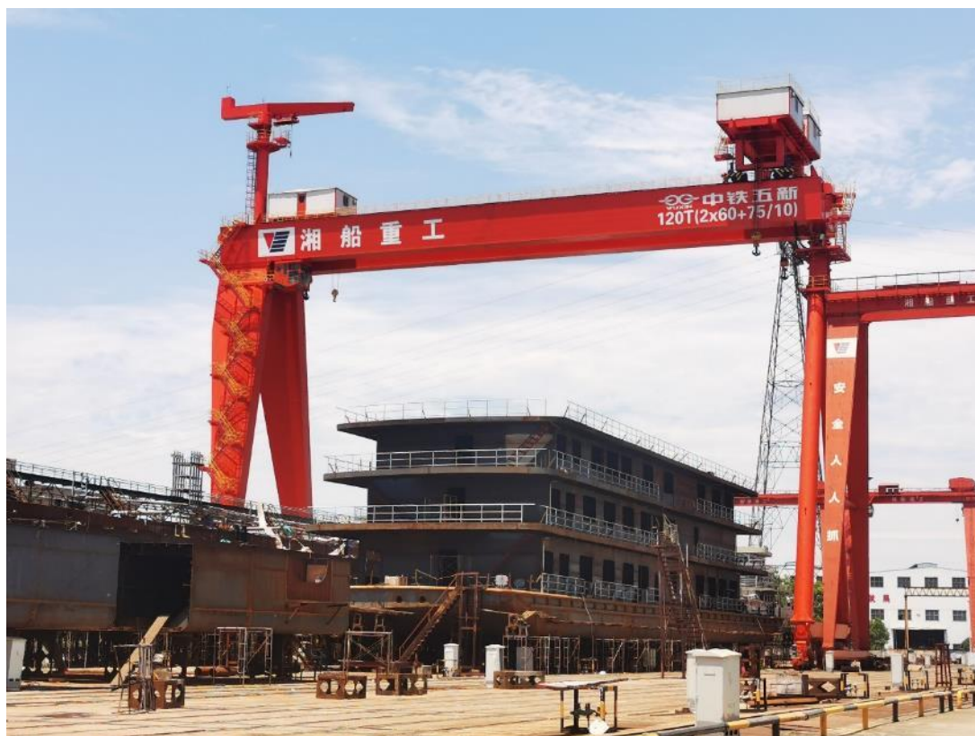
图：造船门式起重机施工实景
