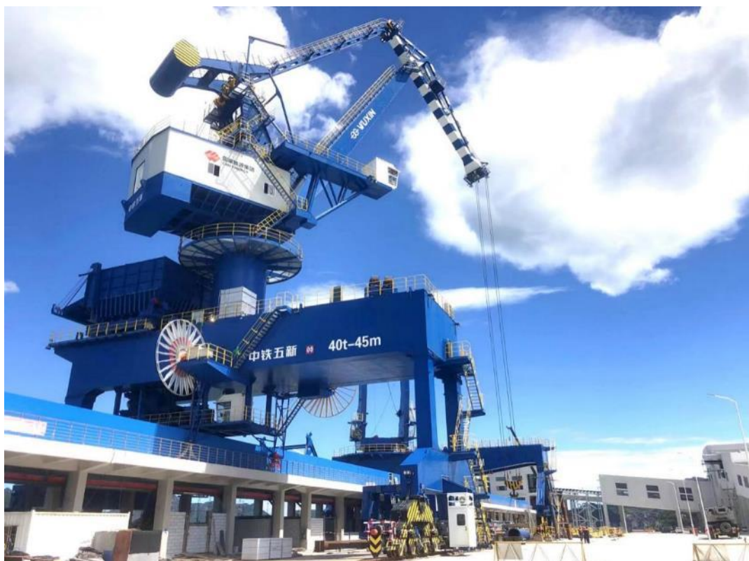
图：带斗门座起重机施工实景
