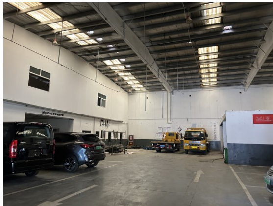
生产车间(厂房部分内部三)
