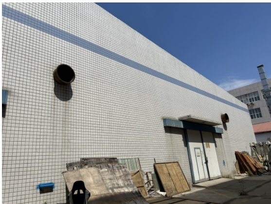
生产车间(厂房部分外部)
