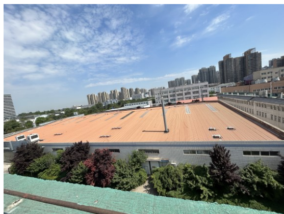
生产车间顶部
