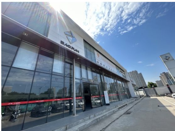
生产车间(4S 部分外部)
