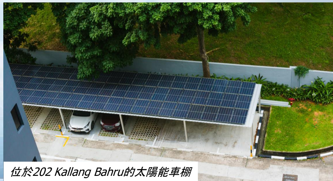
位於Jalan Papan的太陽能車棚
