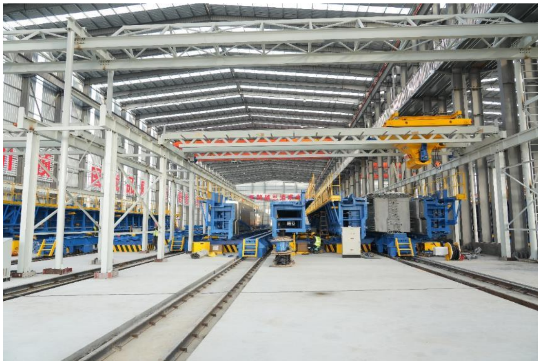
图：T 梁预制场施工实景
