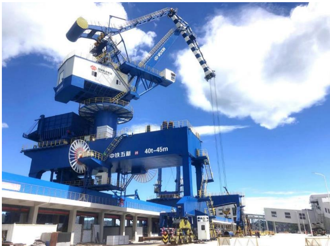
图：带斗门座起重机施工实景
