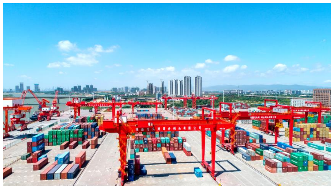
图：轨道式集装箱起重机施工实景
