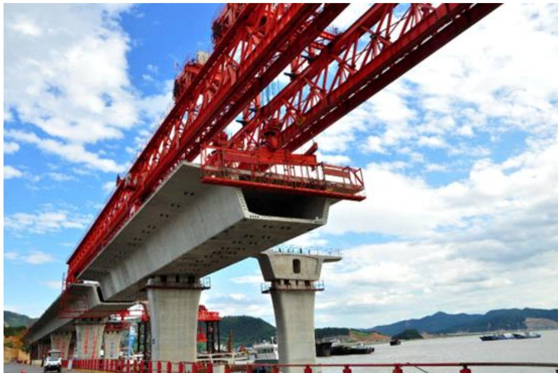
图：节段梁架设实景
