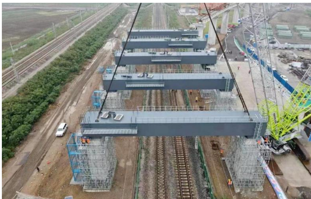
图：门式墩钢梁施工实景
