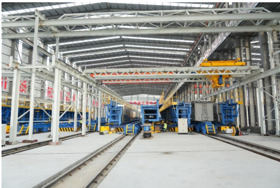
图：T 梁预制场施工实景
