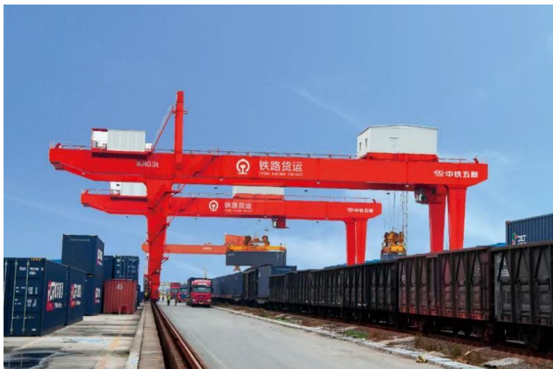
图：铁路货场门式起重机施工实景
