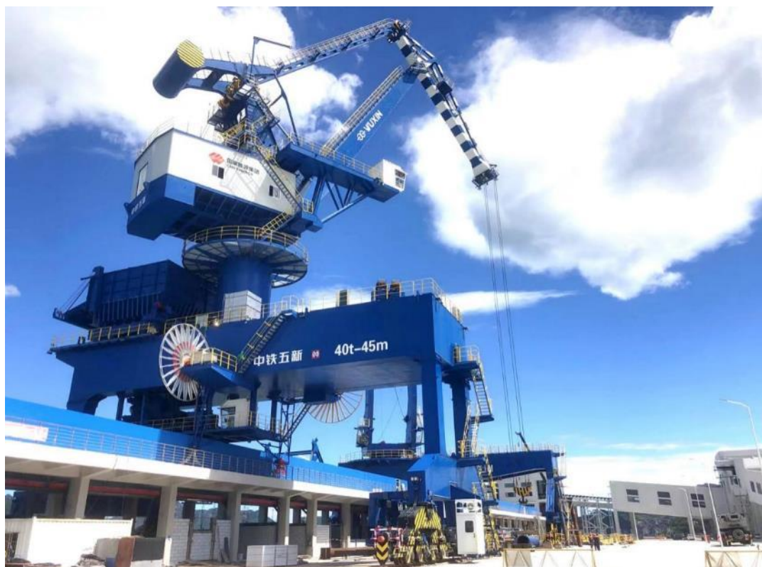
图：带斗门座起重机施工实景
