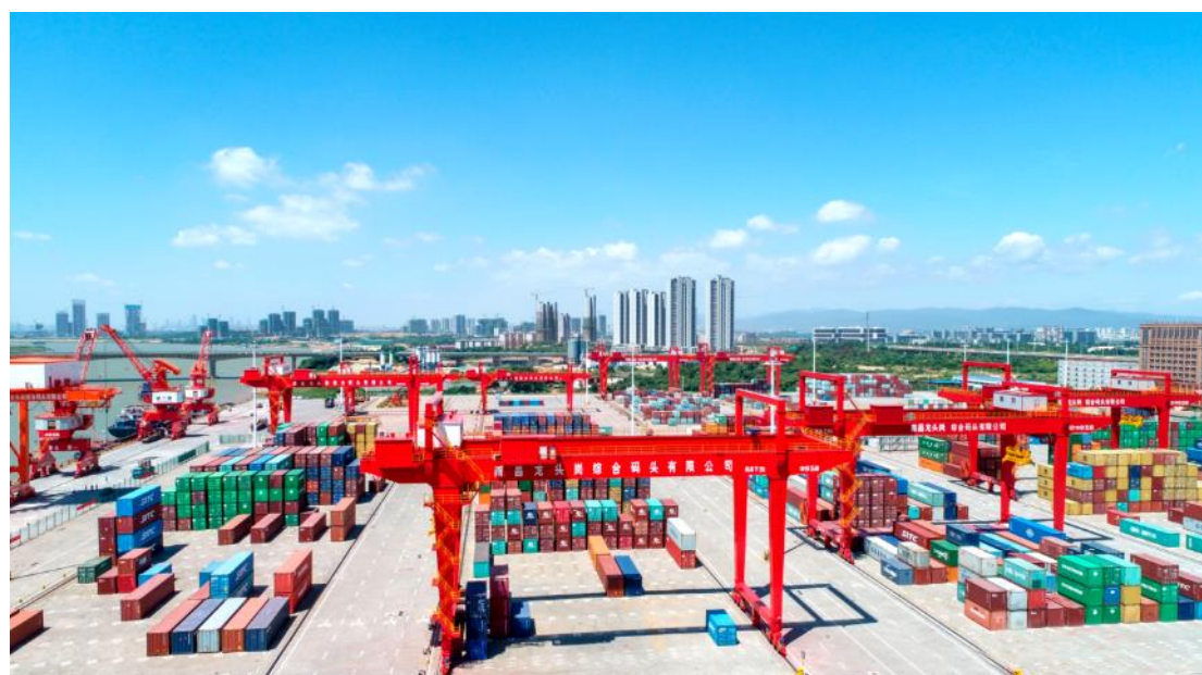
图：轨道式集装箱起重机施工实景
