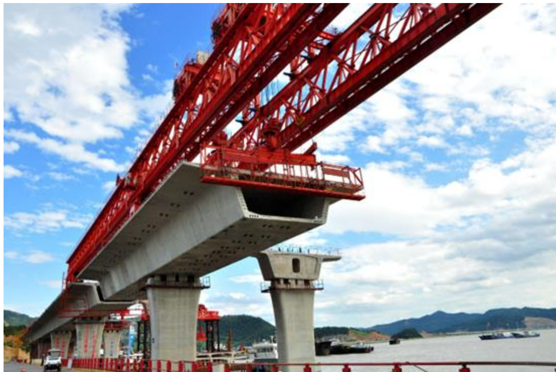
图：节段梁架设实景
