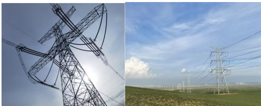
图：宁夏-湖南±800kV特高压直流输电工程&张北-胜利1000千伏特高压交流工程
