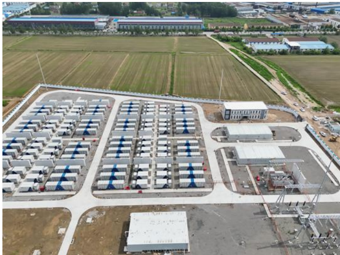
图：阜宁县东沟镇160MW/320MWh共享储能电站项目
