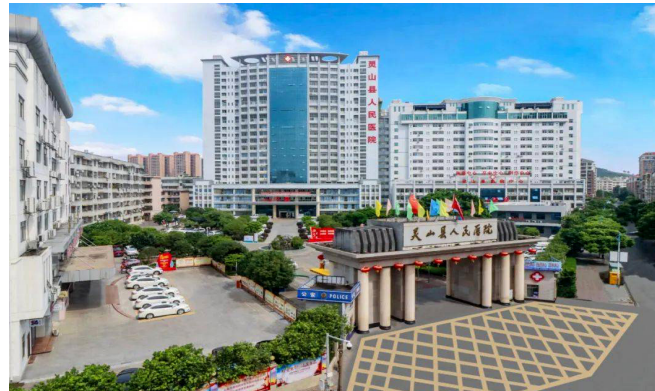
灵山县人民医院急诊综合楼六层会议室修缮加固工程
