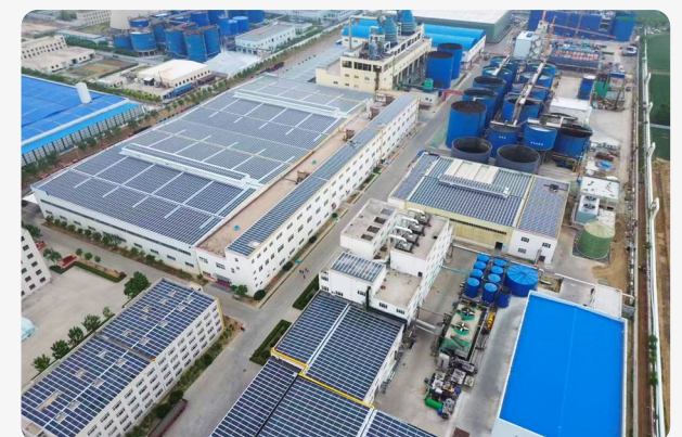
① 山东肥城精制盐厂微逆 BIPV 项目
