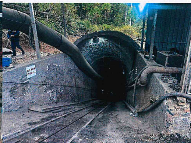
正在施工专用斜风井
