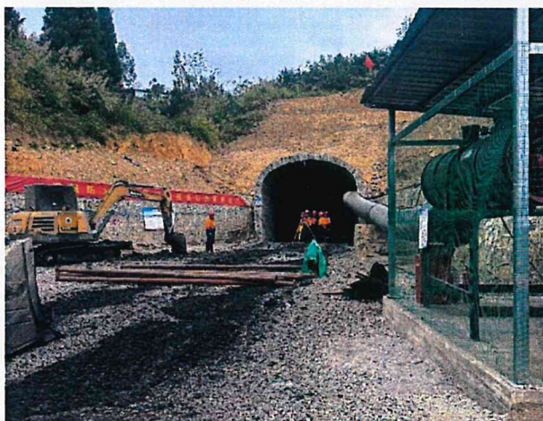
正在施工斜坡道
