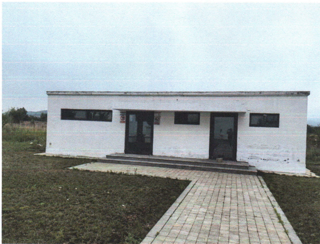
惠河路-90-18 号消防泵房
