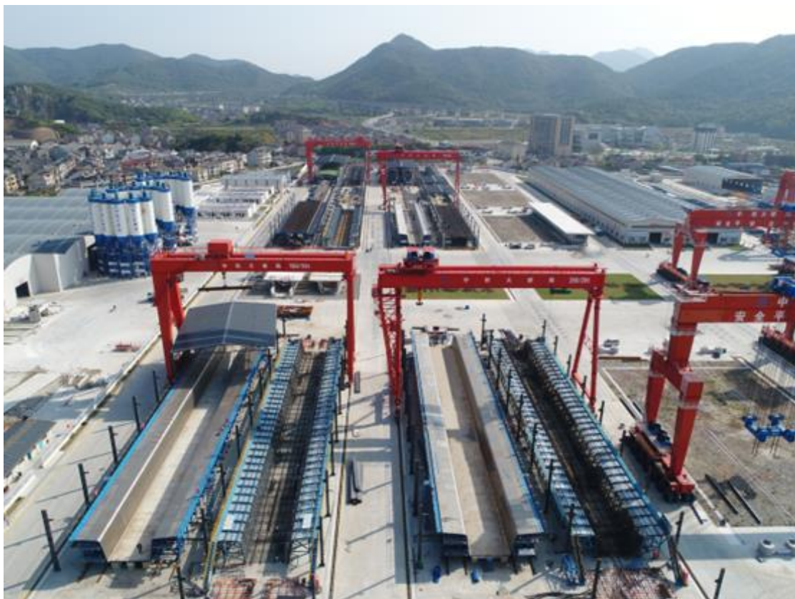
图：整孔梁预制场施工实景
