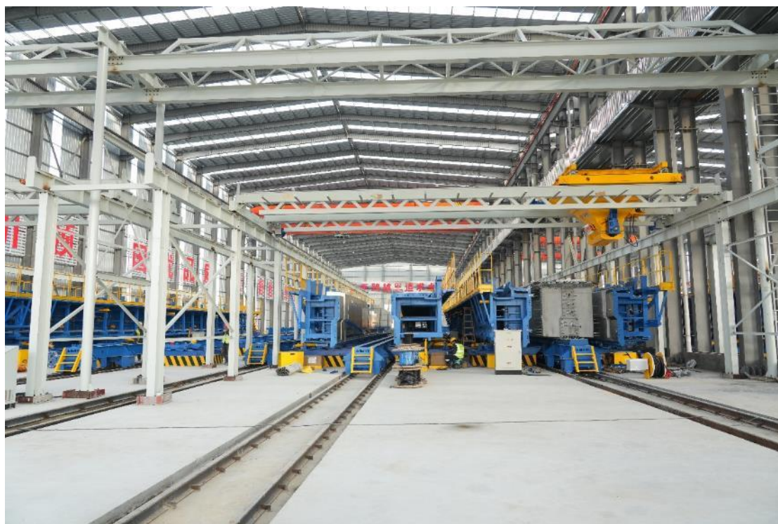
图：T 梁预制场施工实景
