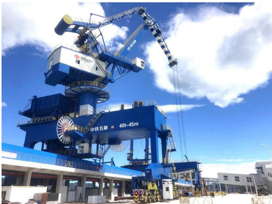
图：带斗门座起重机施工实景
