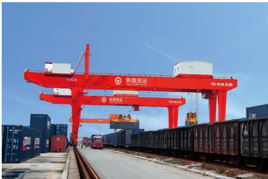
图：铁路货场门式起重机施工实景
