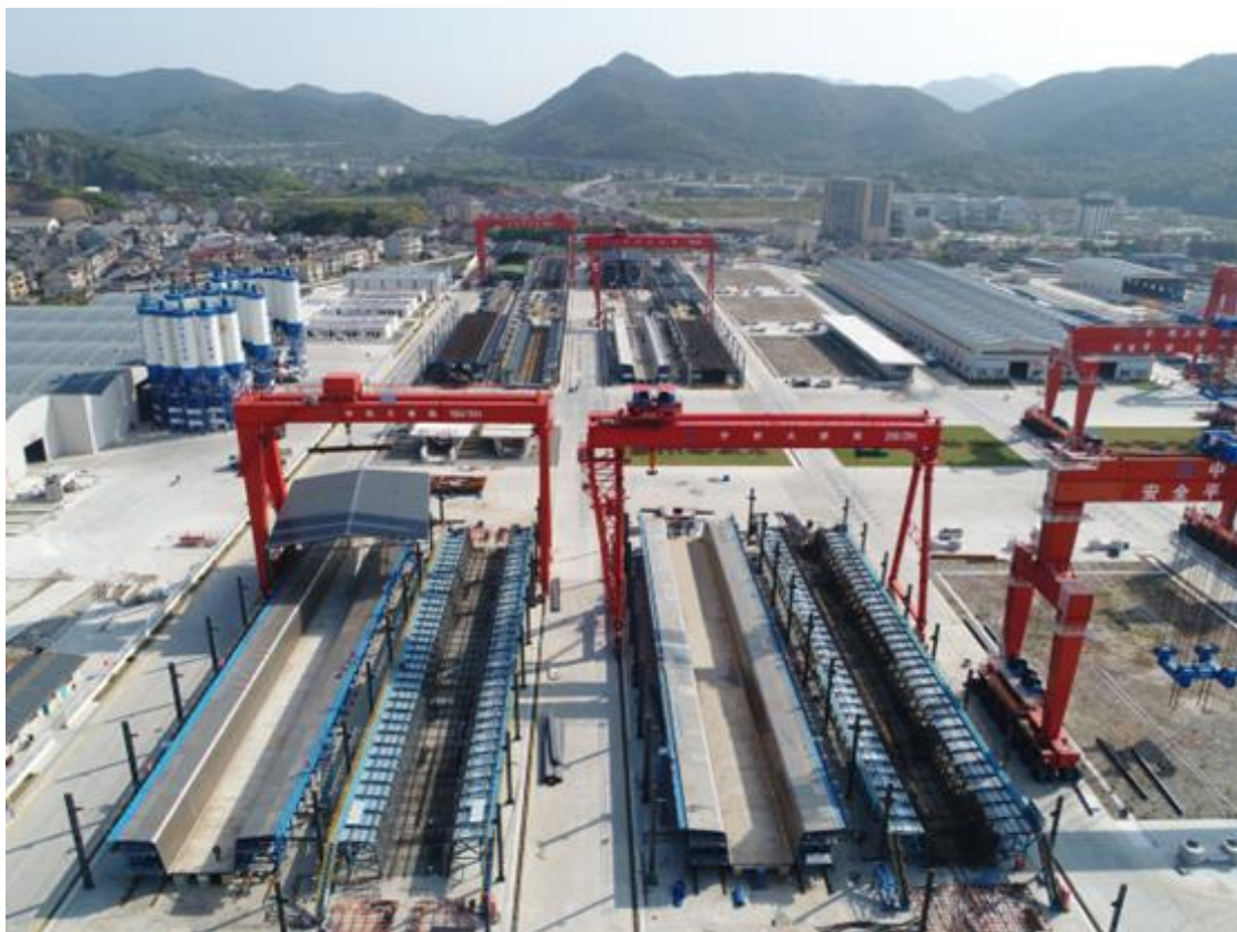
图：整孔梁预制场施工实景
