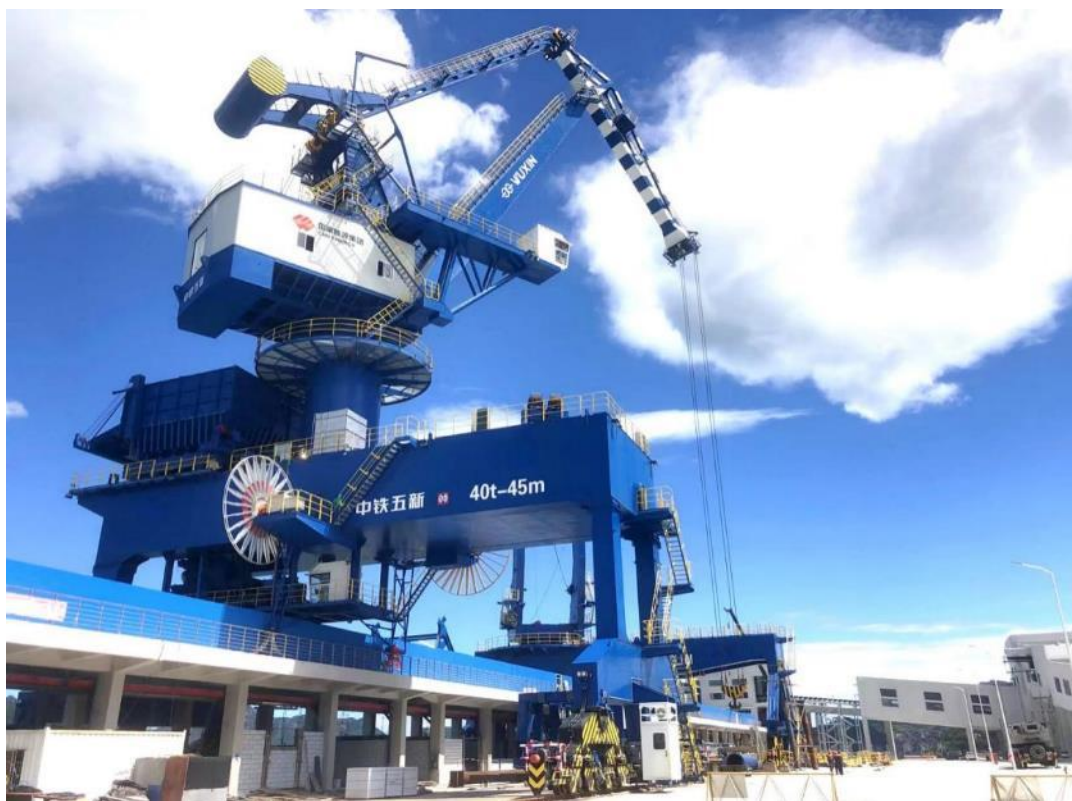
图：带斗门座起重机施工实景
