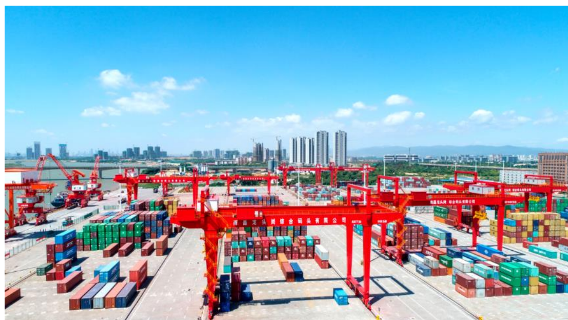
图：轨道式集装箱起重机施工实景
