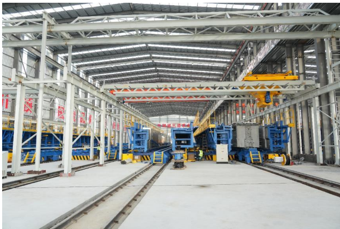
图：T 梁预制场施工实景
