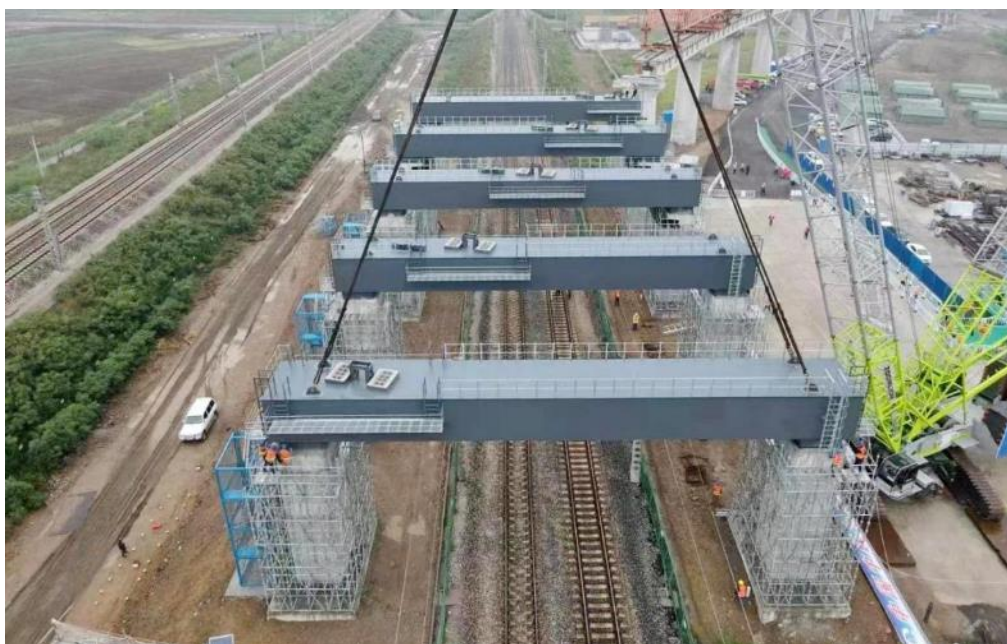
图：门式墩钢梁施工实景
